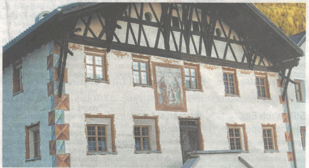
Die Restaurierung des Schlosserhauses in Zams gilt als Vorzeigeprojekt der Ortskernrevitalisierung.
